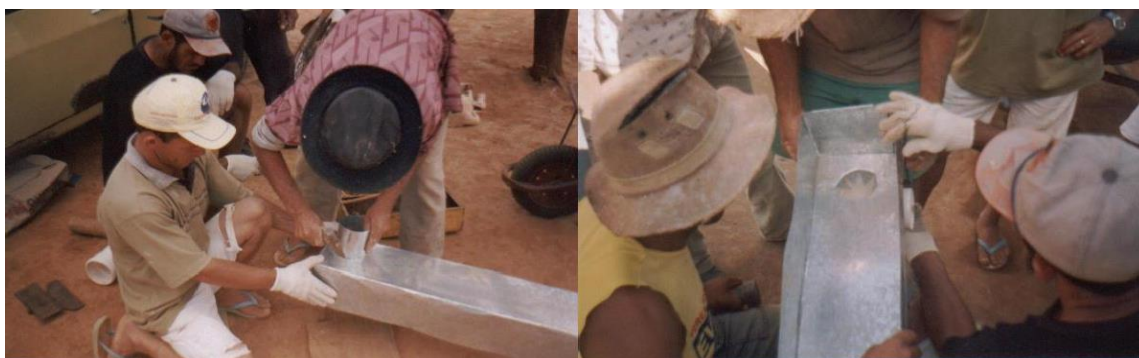
Figura 14: Fixação das calhas de bica
