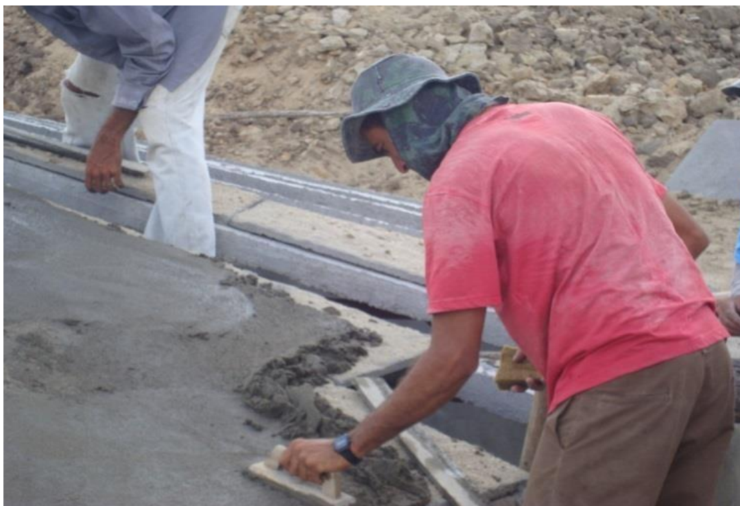
Figura 12: Colocação das placas de cobertura
