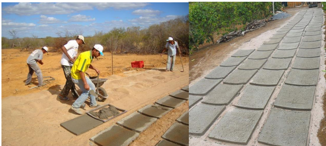
Figuras 2: Confeção das placas da parede da cisterna
