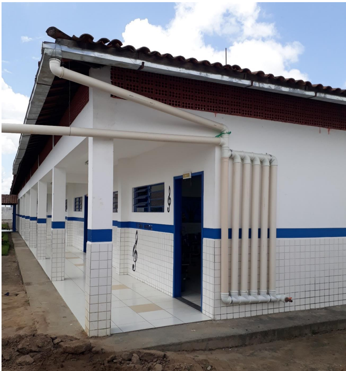
Figura 16: Modelo do dispositivo DesvUFPE para proteção da qualidade da água
