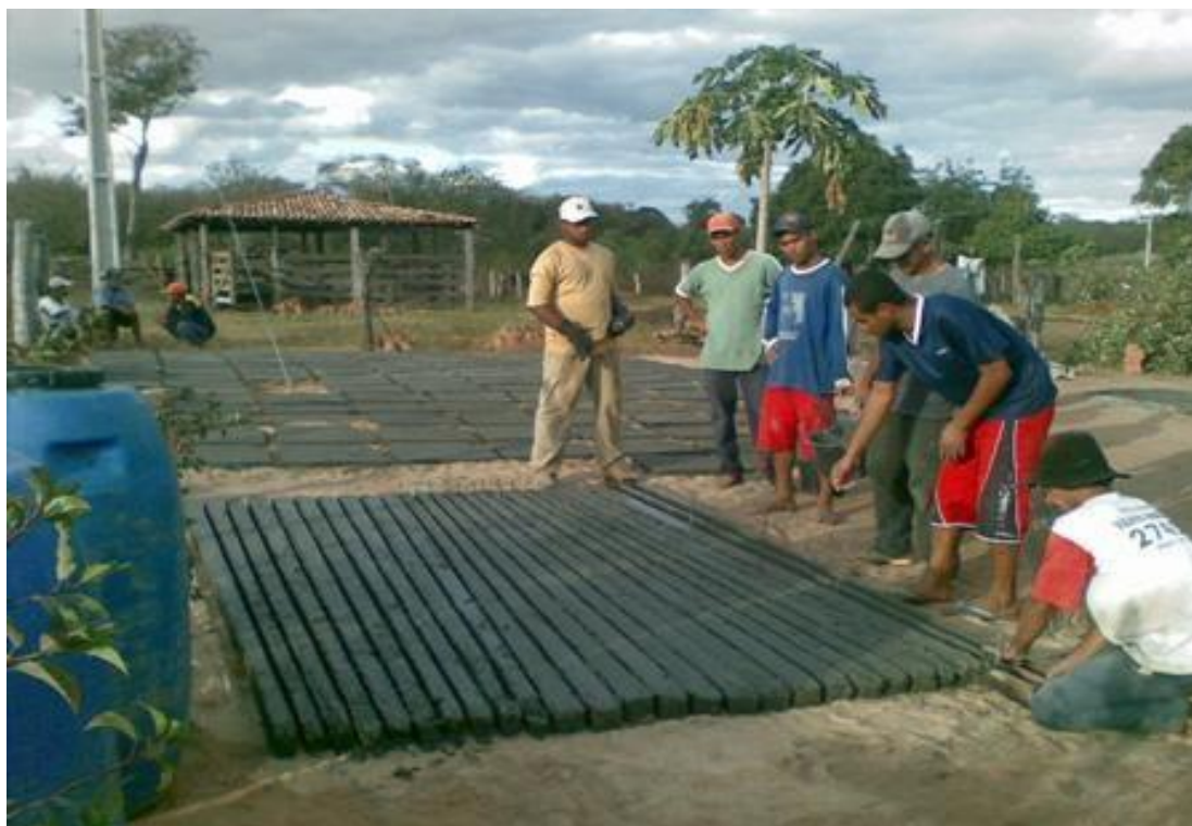
Figura 5: Confeção dos caibros da cobertura da cisterna
