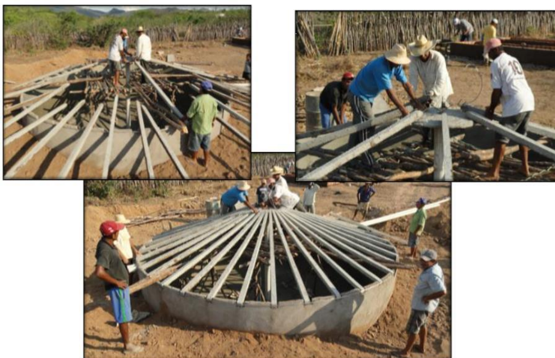
Figuras 11: Colocação dos caibros e da coroa
