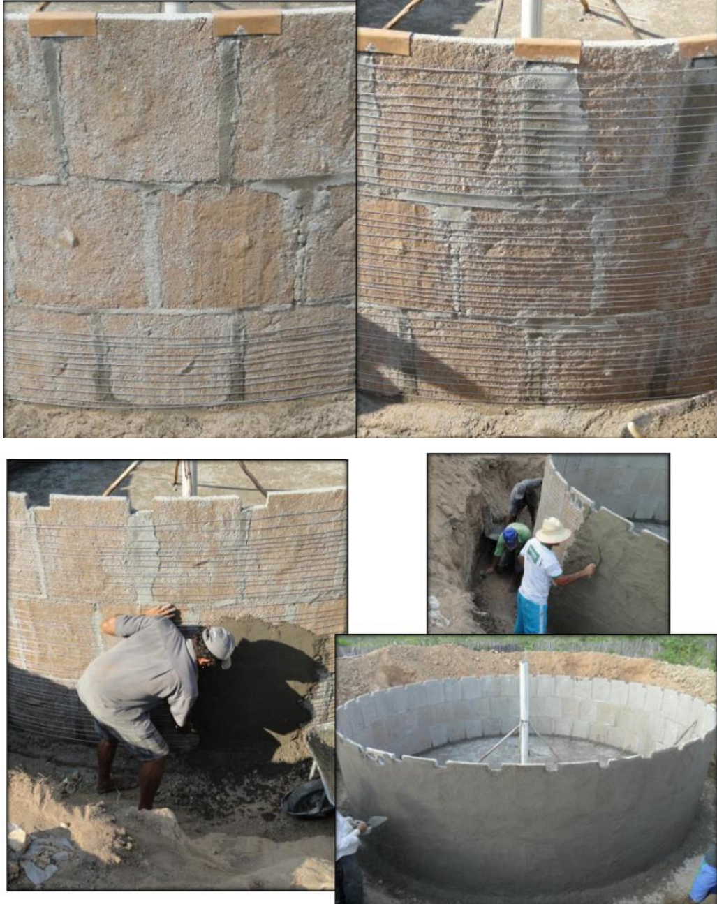
Figuras 9: Arrumação da parede e reboco externo da cisterna
