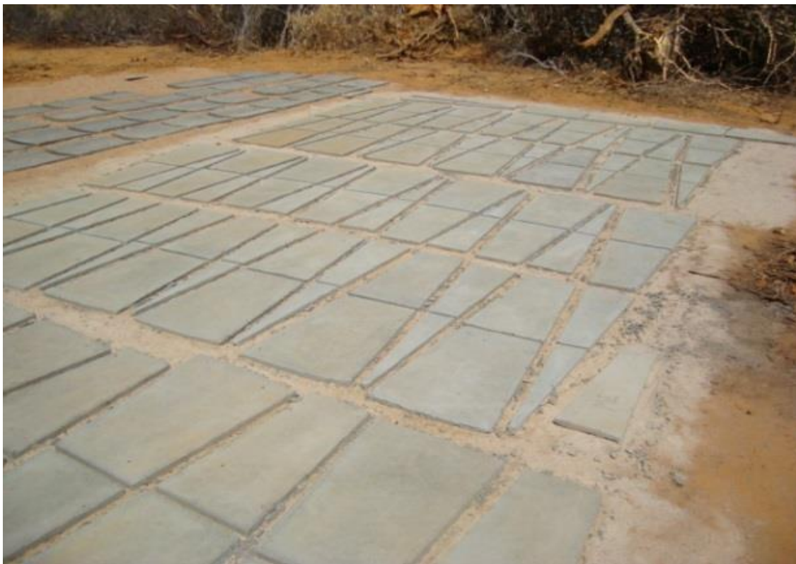
Figura 4: Conjunto de placas da cobertura da cisterna
