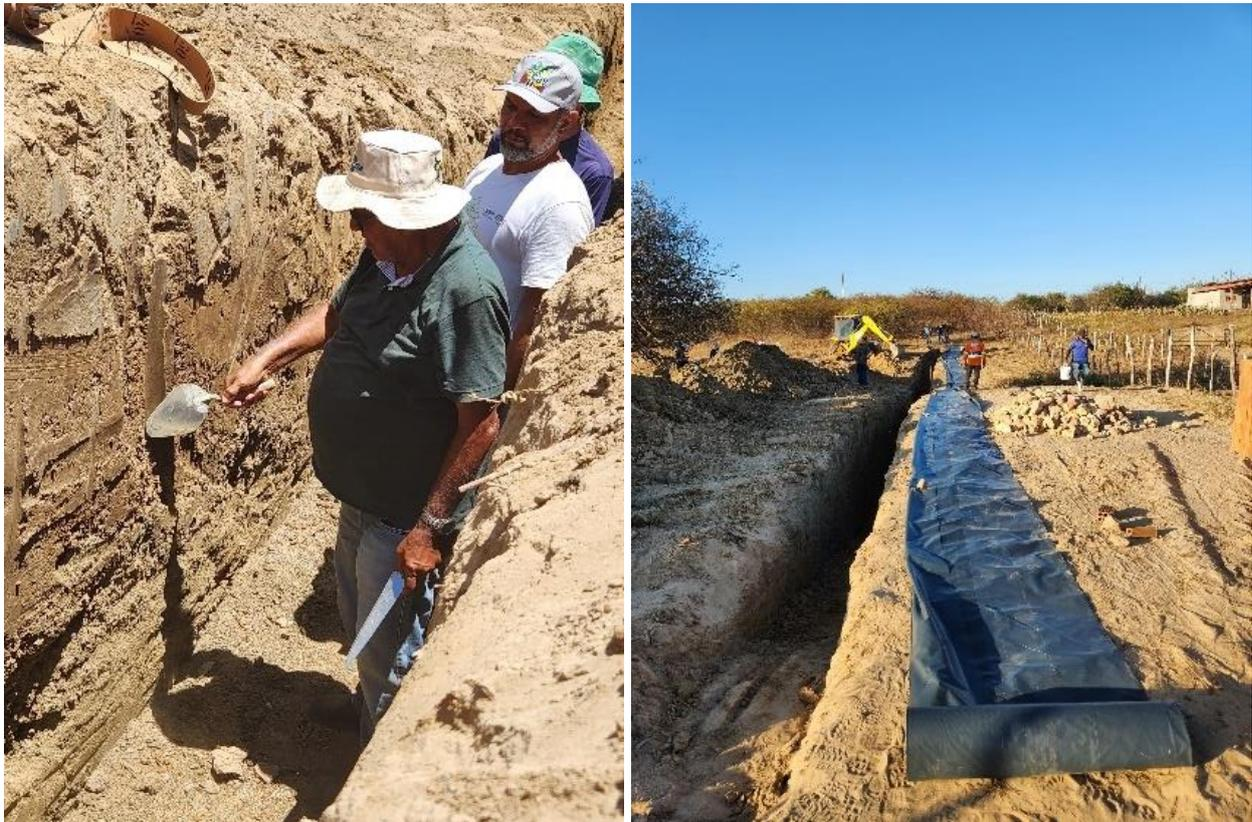
Esse procedimento tem a finalidade de deixar a superfície da vala livre de materiais perfurantes para que possa receber o revestimento com a lona, sem o risco de ocorrer qualquer tipo de perfuração.
