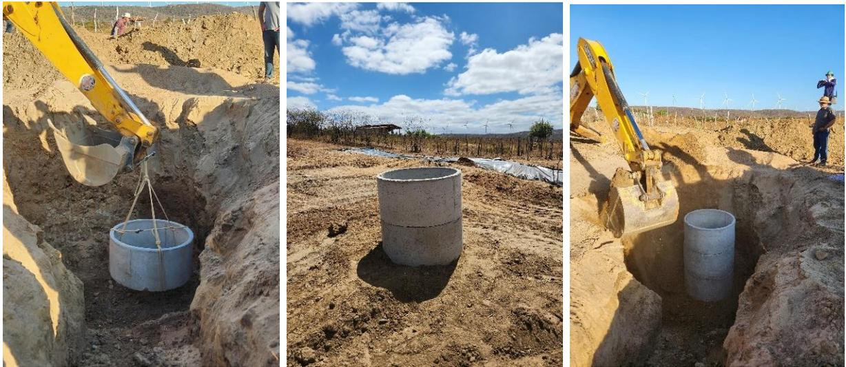
As bordas do revestimento do poço devem se elevar até a altura de 1 m acima do nível do solo.
