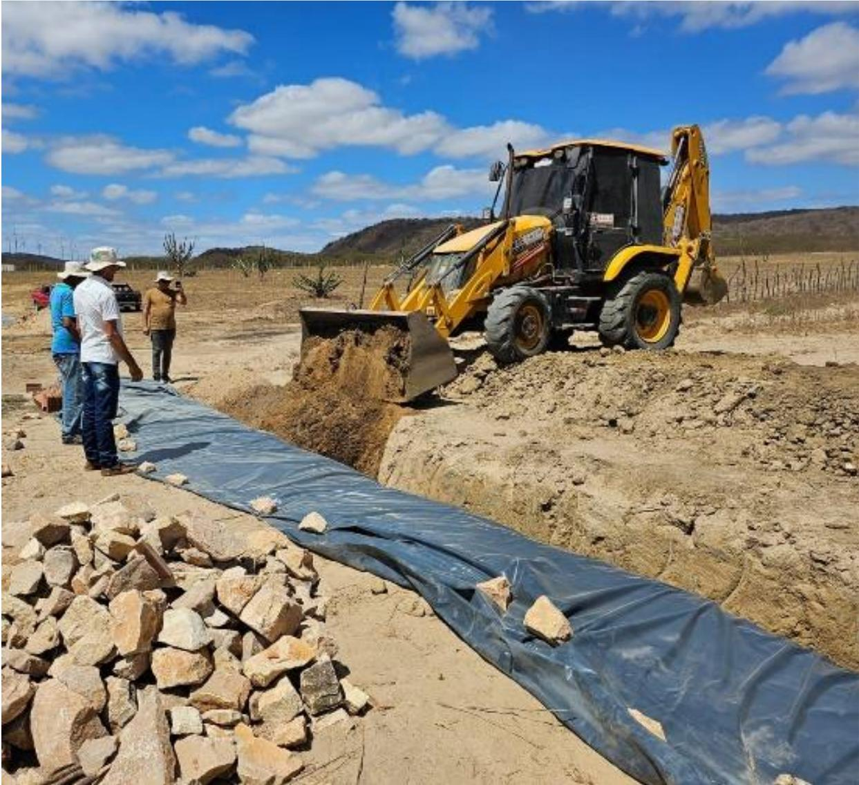
Durante o processo de aterramento, caso a lona seja perfurada, pode-se fazer o remendo com restos de lona, utilizando cola de sapateiro para vedar a parte danificada.
