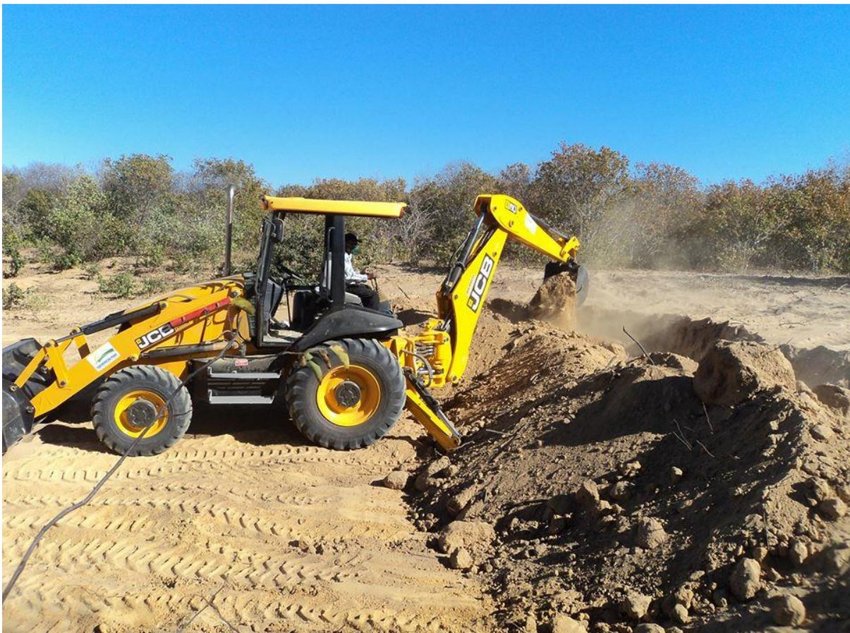
O operador deve observar atentamente o balizamento para que o buraco tenha no mínimo 8,00 m de diâmetro, tendo o cuidado de não aprofundar além dos 1,80 previstos.
