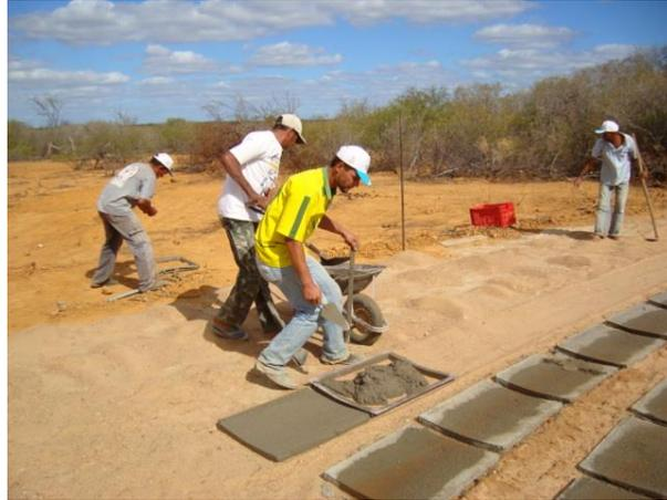
Ao invés de fazer o corte nas placas com o concreto ainda mole, é mais prático preencher o espaço de 10 x 10 cm no canto indicado do molde, parafusando um quadrado de madeira com as dimensões indicadas, de modo a obter as placas diferenciadas.
