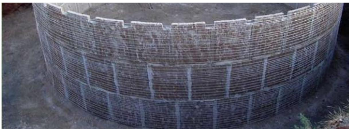
A amarração pode ser feita 1 hora após o levantamento das placas e deve ser iniciada pela base (todas as voltas de arame deverão ser bem distribuídas na parede da cisterna).
