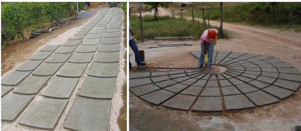
Para a confecção das placas, é utilizada a mistura/traço de 4 latas de areia e 1 lata de cimento. A forma deve ser preenchida com essa mistura devendo ficar bem compactada e alisada com a colher de pedreiro e retirada cuidadosamente.
