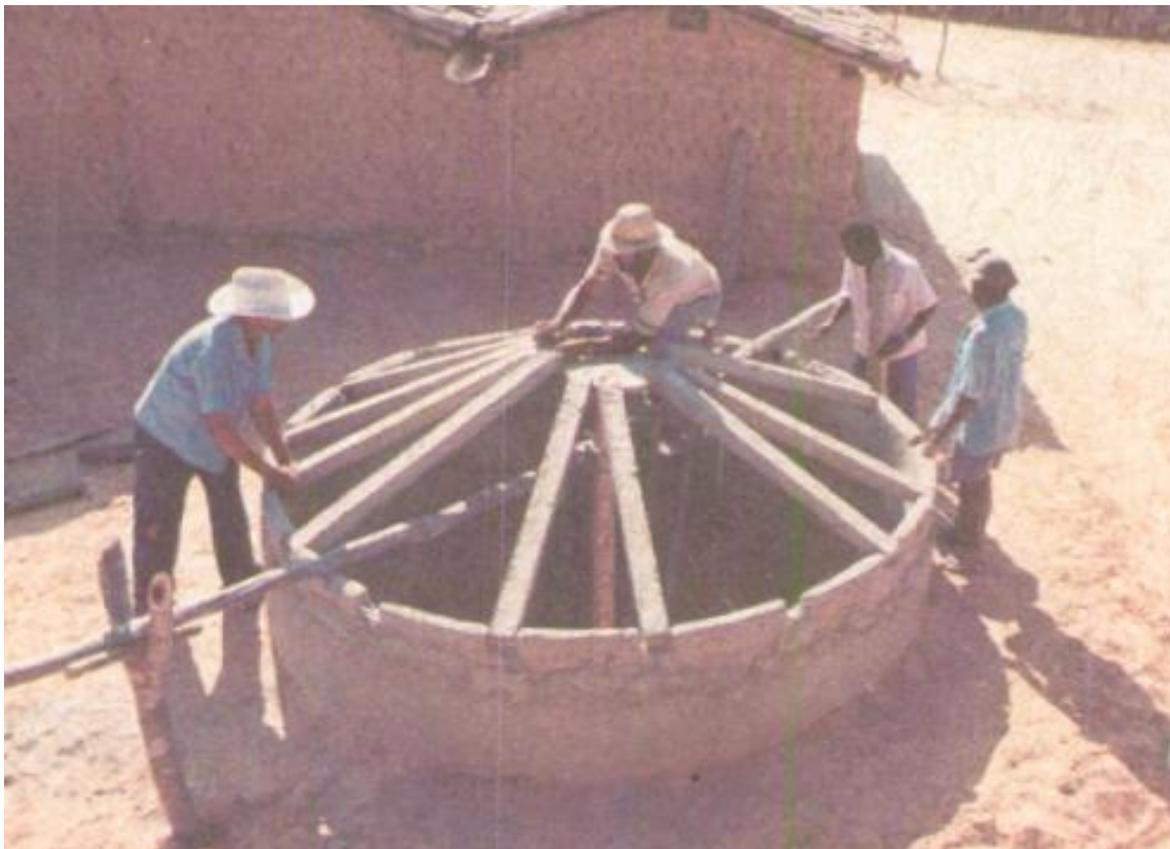
Em seguida, procede-se com a instalação das placas do teto, finalizando com o reboco, conforme demonstrado nas imagens abaixo.
