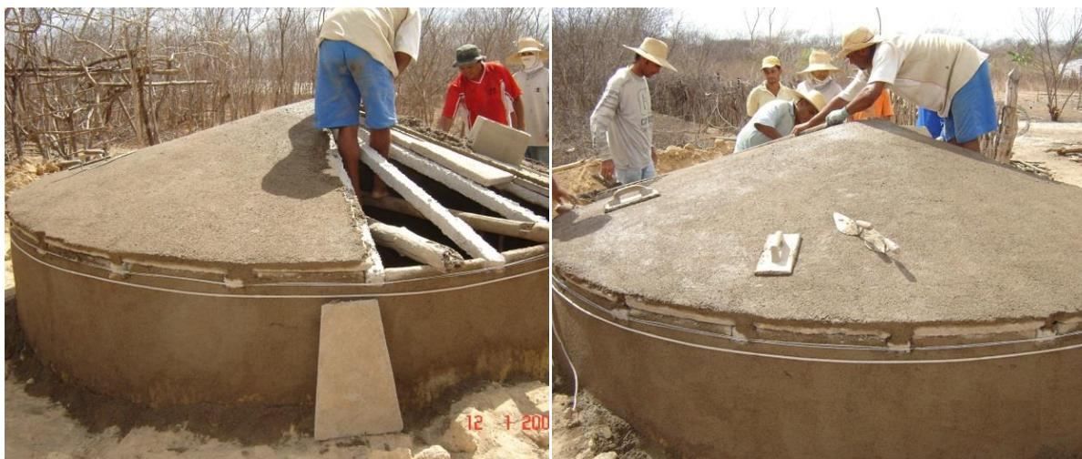
Para o reboco do teto, deve ser utilizado traço de 5 latas de areia para 1 lata de cimento.
