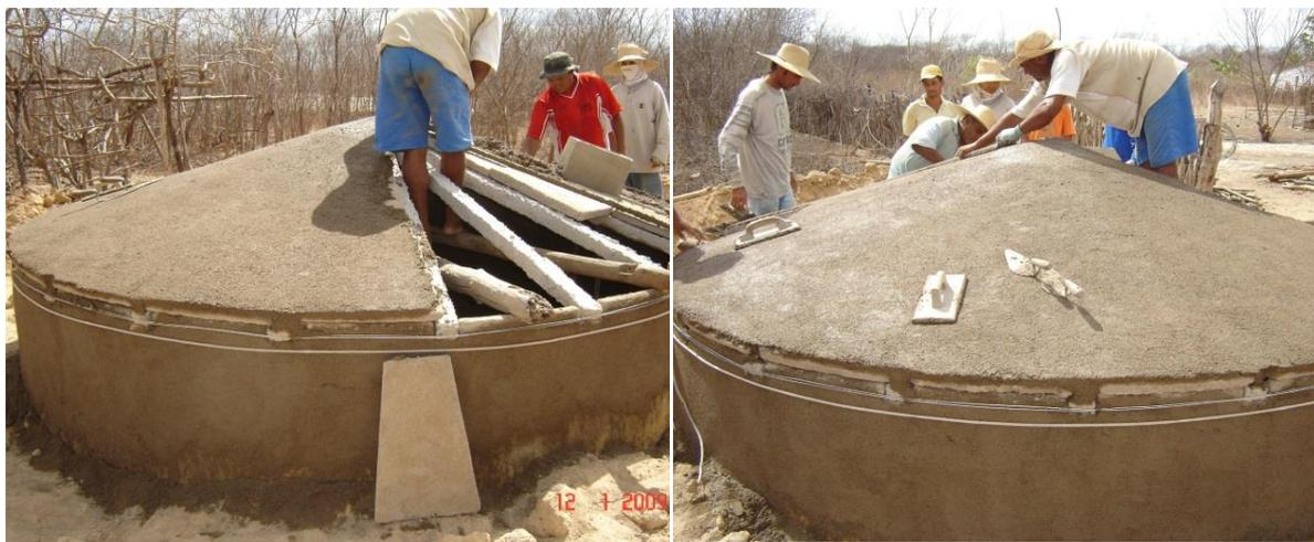
Para o reboco do teto, deve ser utilizado traço de 5 latas de areia para 1 lata de cimento.
