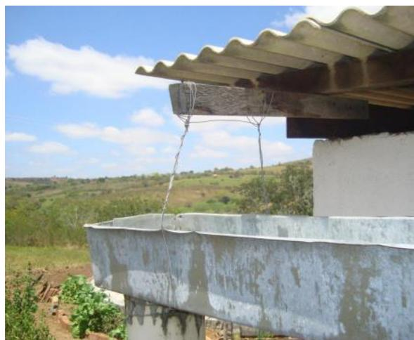
Junto ao sistema de captação de água de chuva deve ser incluído dispositivo para descarte automático para proteção da qualidade da água de chuva captada e armazenada, conforme orientações apresentadas adiante.
