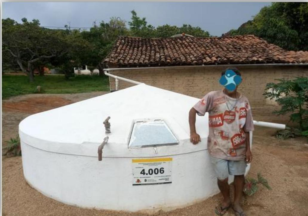
**Foto 2: Visualização do dispositivo de descarte, filtro de barro, calha, telhado e beneficiário**
